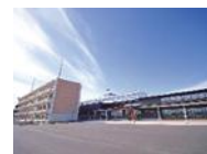
気仙沼市 東日本大震災遺構・伝承館
