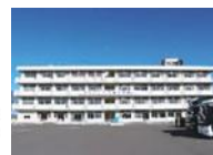
震災遺構 仙台市立荒浜小学校
