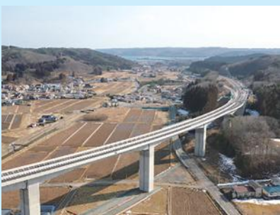
復興道路 （三陸沿岸道路（久慈北～侍浜南））
